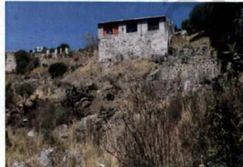
Fotografía 5. Amenaza de caídos por sobrepeso debido a construcción de viviendas a orillas de barranca localidad Azoyatla de Ocampo.
