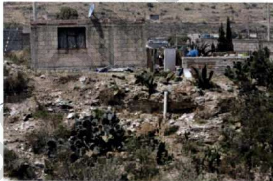
Fotografía 5. Amenaza de caídos por sobrepeso debido a construcción de viviendas a orillas de barranca localidad Azoyatla de Ocampo.
