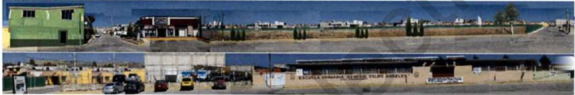
Fotografías 23 y 24. Estado de la imagen urbana en la Calle Reforma.
