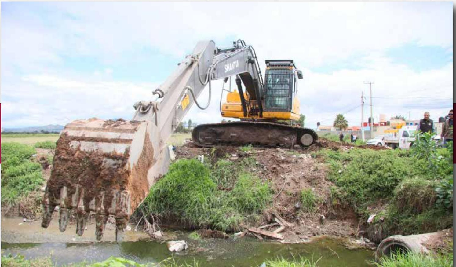
Además, se ejecuta la ampliación y limpieza de la red de drenaje de dichas zonas, así como la intervención en rejillas. Para este tipo de acciones, el municipio hace uso de unidades vector, camiones de volteo, retroexcavadoras y demás maquinaria.
